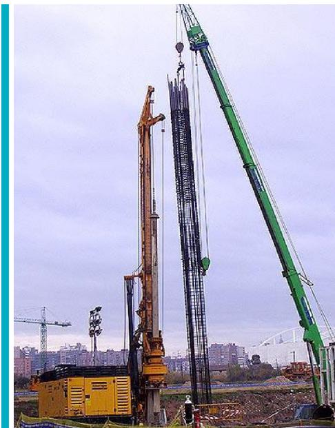
**Figura 10:** Colocación de armaduras a través de grúas.
