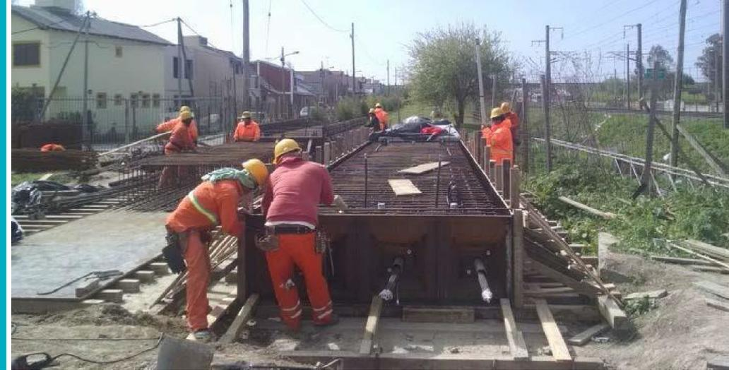
**Figura 14:** Armado de Viga de puente ferroviario. Se colocan las vainas con cables de pretensado.
