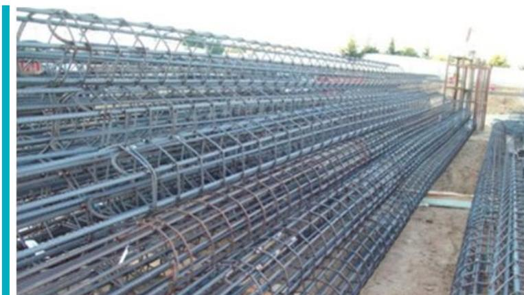
**Figura 9:** Acopio de armadura en banco de trabajo
